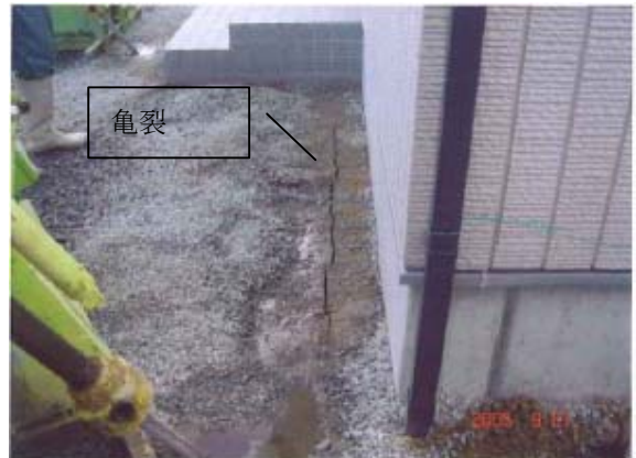
写真-6 注入状況
