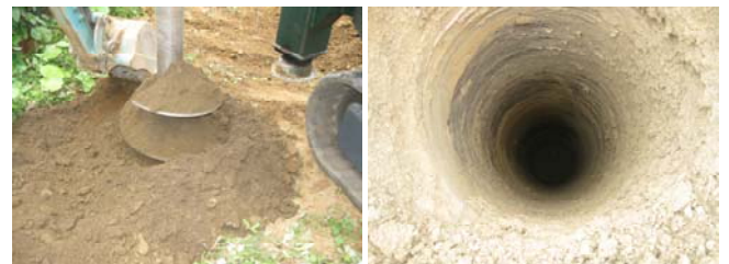
写真-5 切削状況
