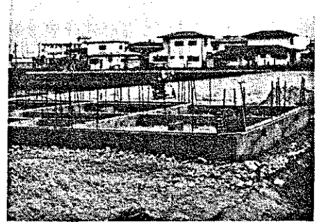
写真-8 ▶ 構築完了
