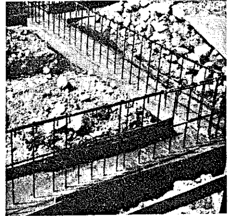
写真-7 ▶ ⑥配筋
