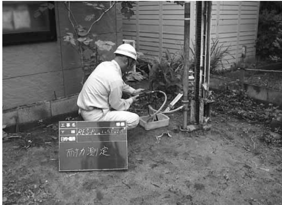
パイプ耐力測定状況
