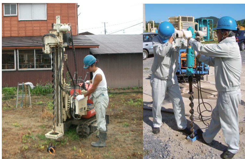
写真 13.2 反力用アンカーの打設状況（左:1号機, 右:2号機）
