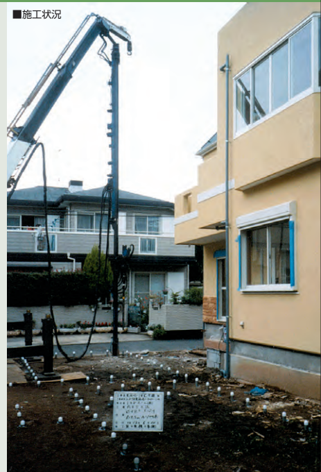
■施工管理設置の例
