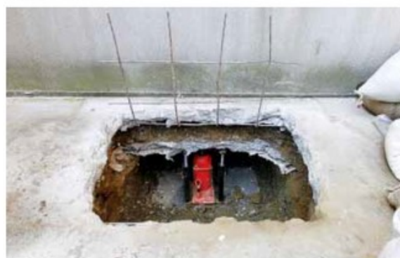
写真-2 耐圧版設置状況
