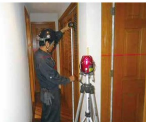
写真-4 内部レーザーレベル測量状況
