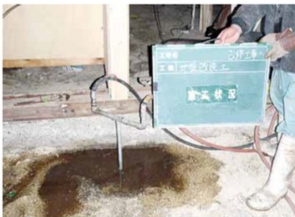
写真-1 基礎下への注入状況
