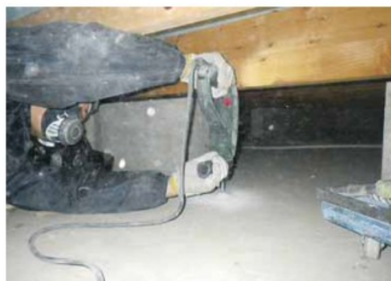
写真-3 注入孔の削孔状況 (基礎スラブ)
