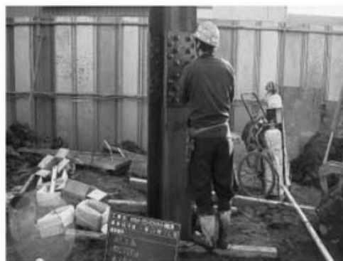
写真-1 沈下抑止杭の施工
