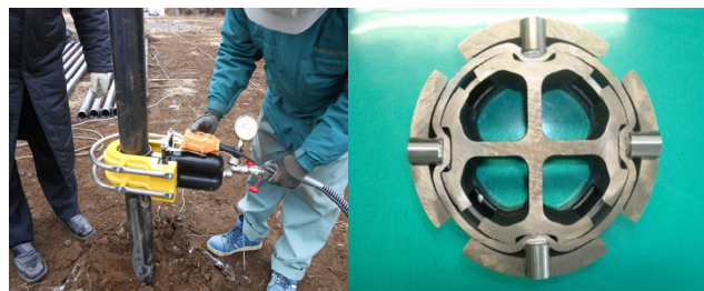
写真 1 加締め状況
