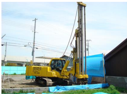
写真－1 施工機械
