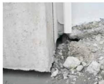
写真-1 ①直接基礎 ②杭状補強体 写真-1 杭状地盤補強工法で対策された建物基礎の液状化後の基礎状況
