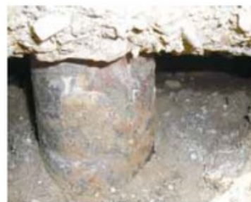
写真-1 ①直接基礎 ②杭状補強体 写真-1 杭状地盤補強工法で対策された建物基礎の液状化後の基礎状況
