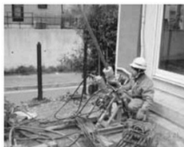
写真-3 斜め削孔・注入状況
