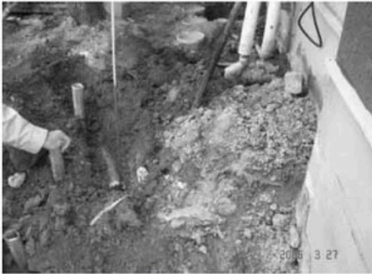
写真-1 薬液流出防止用パイプの打設状況
