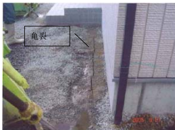
写真-6 注入状況
