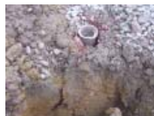
写真-5 パイプ打設（左）とパイプ抑止効果状況（右）
