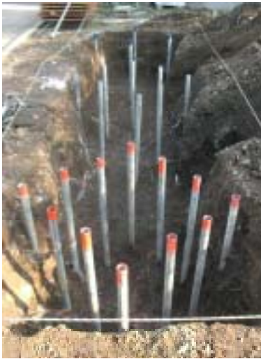
写真-1 注入固化体の掘出調査状況
