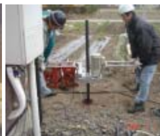
写真-4 パイプ打設状況
