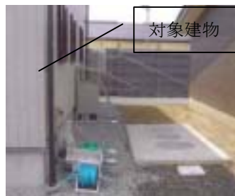
写真-3 建物と浄化槽の配置
