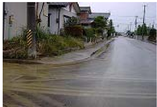
写真1. 填砂跡(見附市南本町)
