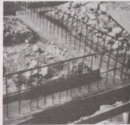
写真-7▶ ⑥配筋
