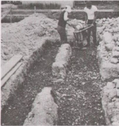
◀写真-6 ⑤砂利転圧
