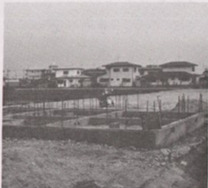
写真-8▶ 構築完了
