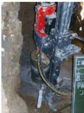
写真-2 コアドリルによる擁壁底板コアリング状況
