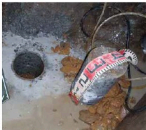
写真-3 擁壁底板コアリング完了状況
