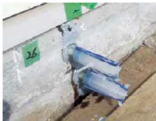
写真-5 エポキシ樹脂注入状況
