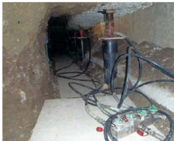
写真-4 鋼管圧入状況
