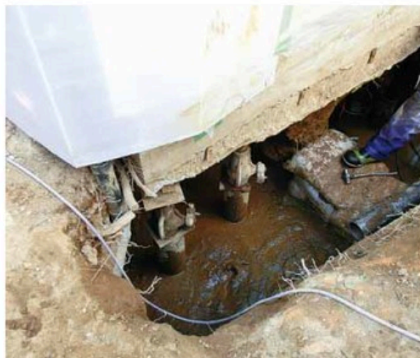
写真-1 鋼管圧入セット状況
