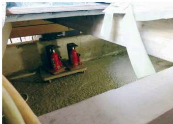
写真-5 土台上げ工法による施工状況（水平確認後、基礎立上がり上部に見られる隙間に基礎を嵩上げる）
