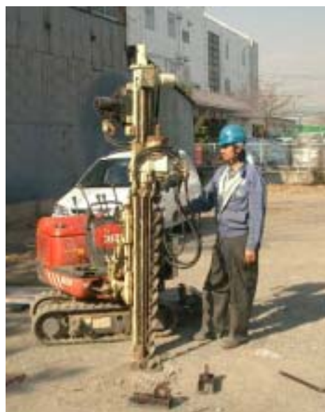
写真3 アンカー設置状況
