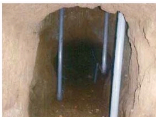
写真-2 注入管配置状況（縦孔部）
