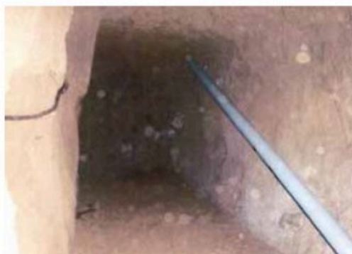
写真-3 注入管配置状況（奥側）
