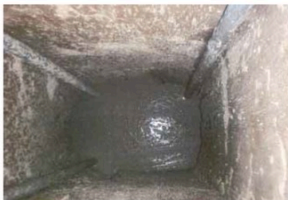
写真-5 最終日の充填注入状況（縦孔）
