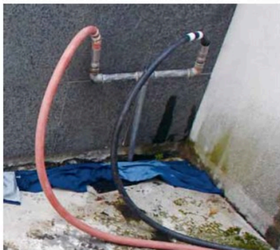
写真-1 建物基礎下への空洞充填注入状況 (2液混合タイプの薬液使用)
