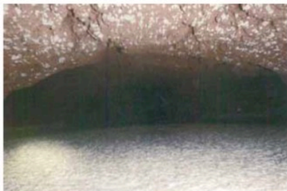
写真-4 1日目の充填注入完了状況（横孔）
